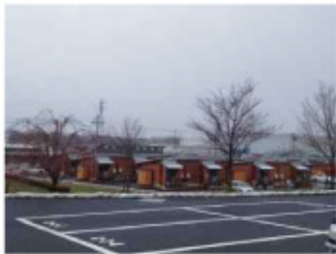
恵向公園内に作られている ログハウスのような仮設住宅
