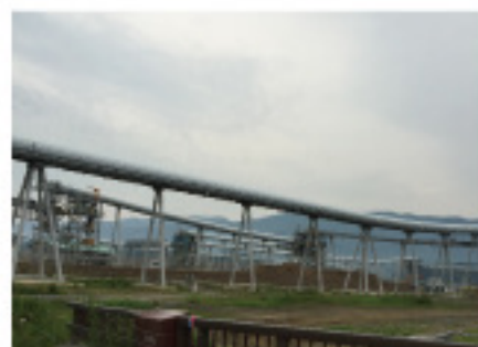
陸前高田の街にはベルトコンベアーが張り巡らされ盛り土作業が進んでいます
